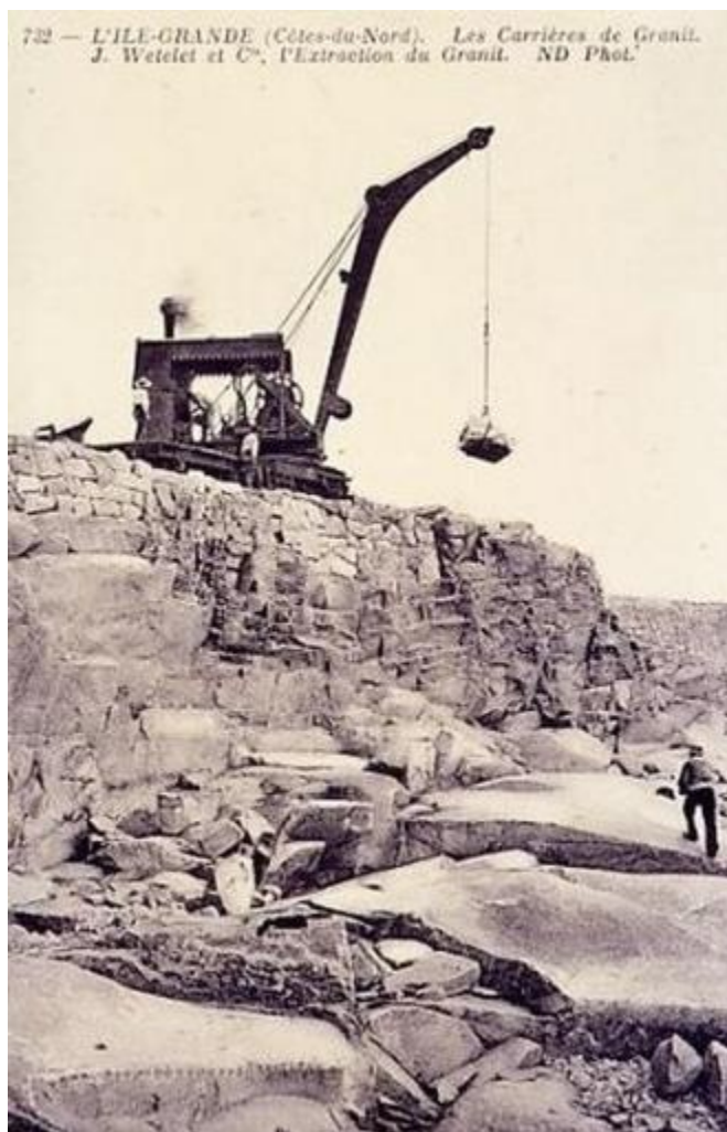
La grue à vapeur de l'entrepreneur Watelet à la carrière de Kastell Erek (collection particulière)
