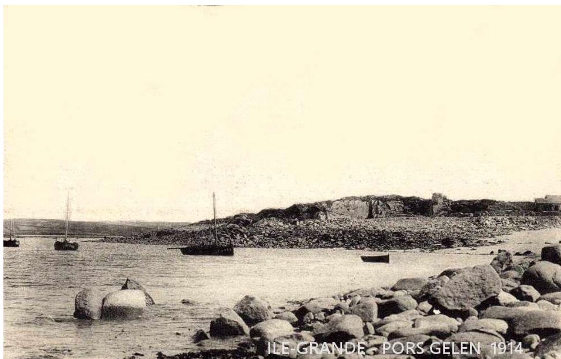
Au début du XXe s : au fond : la carrière ; à droite : le bâtiment des soudiers.
