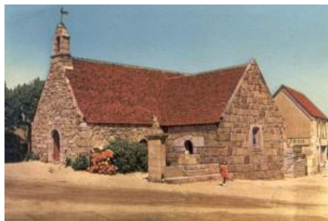
Cette photo injustement colorisée après-guerre montre la croix décapitée par fait de guerre mais rejointe par le christ du calvaire du bourg victime de la foudre dans les années vers 1912.
